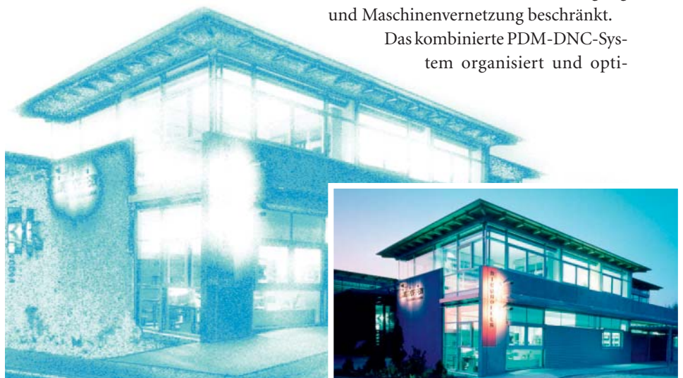
1 Ringhoffer-Gebäude in Kohlberg: Zum Erfolgsrezept des 130 Mitarbeiter großen Unternehmens gehört es, auch in schwierigen Fällen individuelle Lösungen entwickeln zu können
